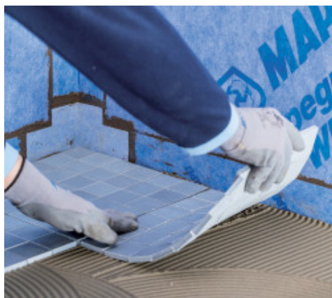
Posa della piastrellatura
