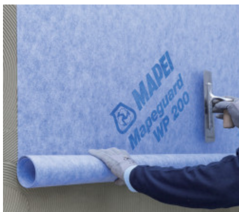
Posa di Mapeguard WP 200
