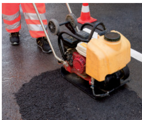
Compattazione meccanica di Mape-Asphalt Repair 0/8
