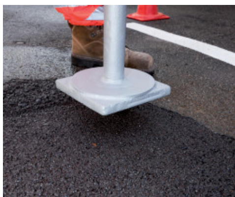
Compattazione manuale di Mape-Asphalt Repair 0/8
