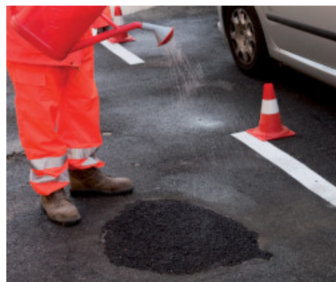
Bagnatura della superficie di Mape-Asphalt Repair 0/8
