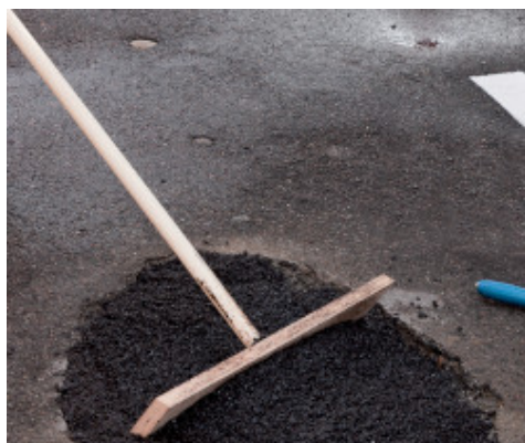
Applicazione e stesura di Mape-Asphalt Repair 0/8
