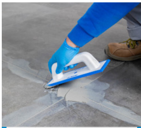
Stuccare la superficie del locale
