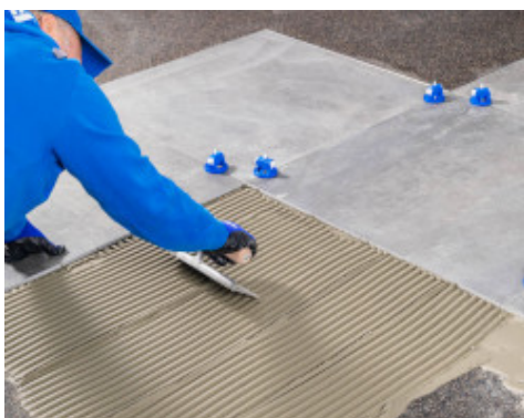
Su supporto adeguatamente preparato, procedere alla stesura dell'adesivo per l'incollaggio dei teli fonoisolanti
