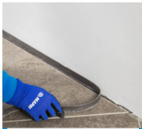
Ad indurimento della stuccatura, rifilare il bordo perimetrale tagliando la parte eccedente di Mapesonic Strip
