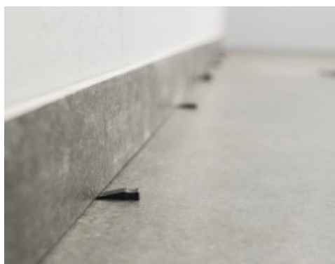
Applicare la zoccolatura perimetrale facendo in modo che non vi sia diretto contatto con la pavimentazione
