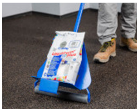
Massaggiare la superficie con un rullo rigido o con una spatola piana, partendo dal centro verso l'esterno
