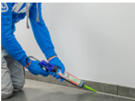
Sigillare lo spazio ricavato tra zoccolatura e pavimento con un idoneo sigillante elastico della gamma Mapei
