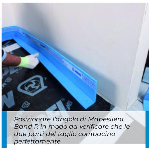
Posizionare l'angolo di Mapesilent Band R in modo da verificare che le due parti del taglio combacino perfettamente
