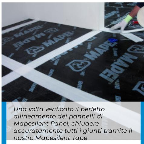
Una volta verificato il perfetto allineamento dei pannelli di Mapesilent Panel, chiudere accuratamente tutti i giunti tramite il nastro Mapesilent Tape
