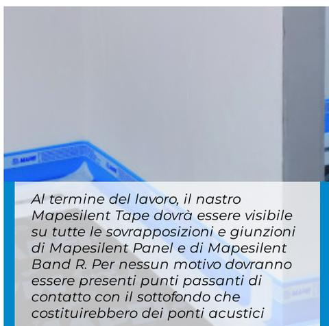
Al termine del lavoro, il nastro Mapesilent Tape dovrà essere visibile su tutte le sovrapposizioni e giunzioni di Mapesilent Panel e di Mapesilent Band R. Per nessun motivo dovranno essere presenti punti passanti di contatto con il sottofondo che costituirebbero dei ponti acustici
