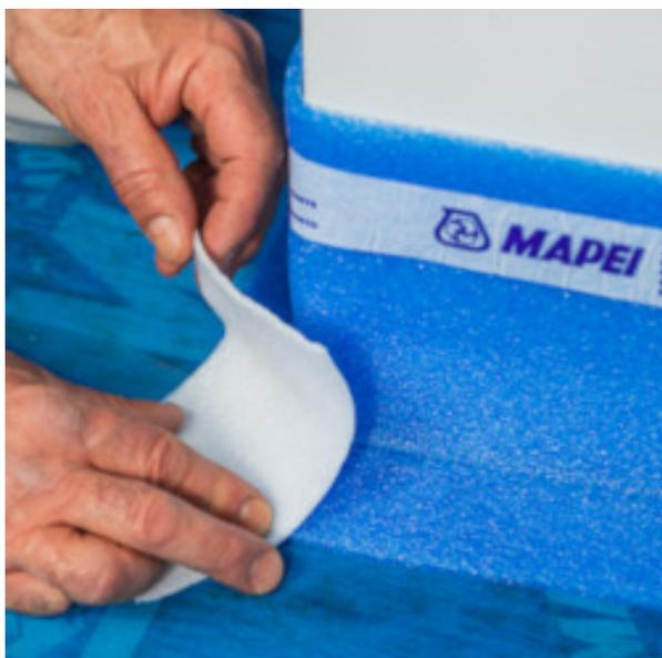
Tagliare e applicare **Mapesilent Tape** negli angoli, nei raccordi di **Mapesilent Band R** e nelle sovrapposizioni tra **Mapesilent Roll** e **Mapeband R** in modo da garantirne una perfetta protezione delle giunzioni
