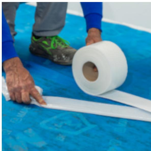
Una volta verificata la perfetta sovrapposizione di **Mapesilent Roll**, chiudere e sigillare tutte le sovrapposizioni con il nastro **Mapesilent Tape**
