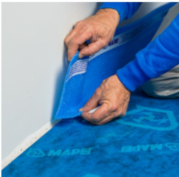
Applicare **Mapesilent Band R** lungo il perimetro del locale rimuovendo il film di protezione sul rovescio
