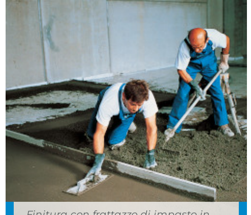
Finitura con frattazzo di impasto in Mapecem
