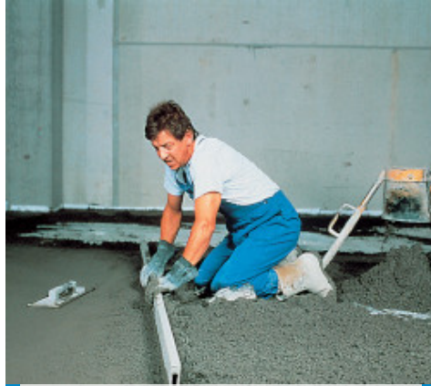
Staggiatura di impasto in Mapecem
