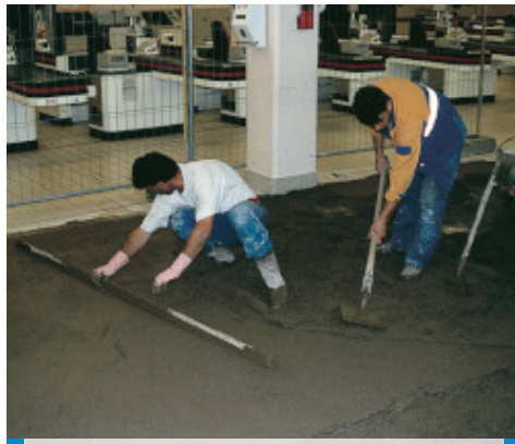
Rifacimento rapido di massetto in un supermercato
