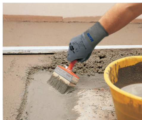
Stesura di boiacca di ancoraggio per massetti in Mapecem aderenti
