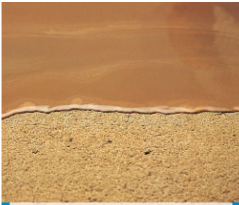
Finitura di massetto in Mapecem con Ultraplan autolivellante
