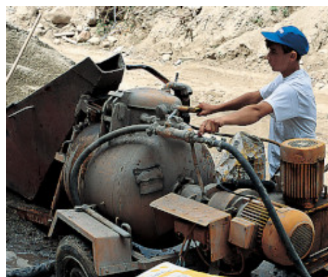
Impasto di Mapecem con impianto automatico di pompaggio
