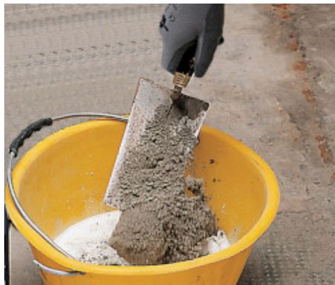
Impasto di Mapecem con Planicrete come boiaccia di ancoraggio
