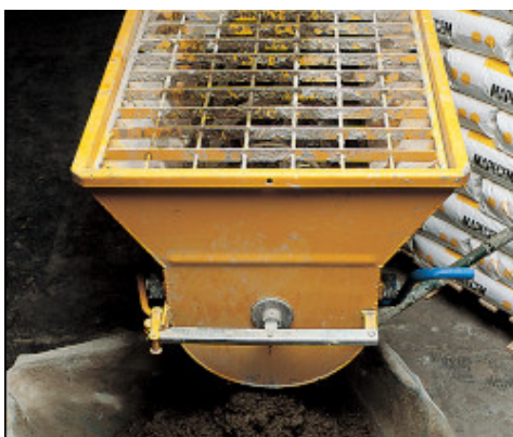
Impasto di Mapecem con minibetoniera
