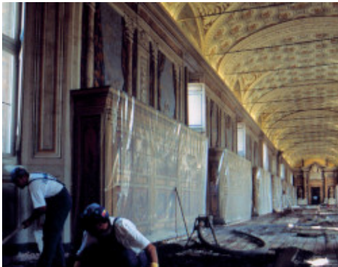
Stesura e finitura del massetto in Mapecem - Saloni Sistini - Città del Vaticano
