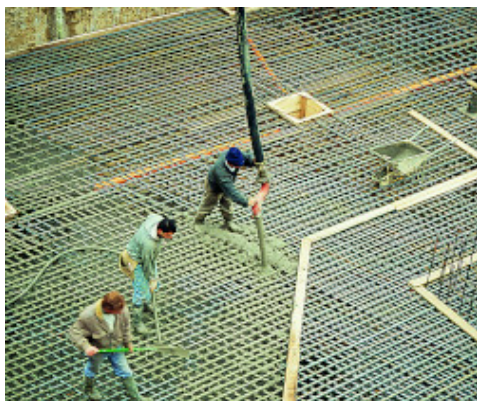
Particolare del getto di platea con Cls superfluido grazie a Mapefluid PZ500
