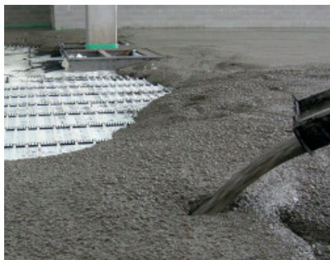
Getto in calcestruzzo con aggiunta di Mapefibre NS18 per contrastare la fessurazione da ritiro plastico
