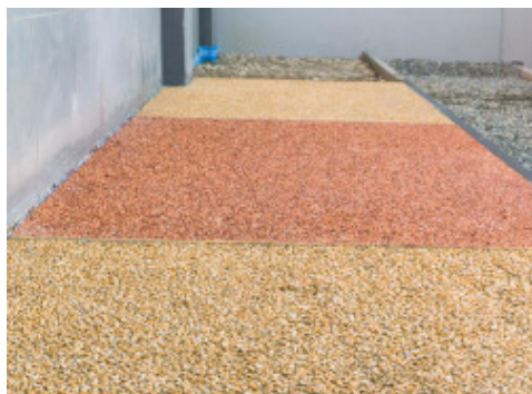
Esempio di pavimentazione architettonica realizzata con prodotti Color Paving e microfibre Mapefibre NS 18 Polymesh
