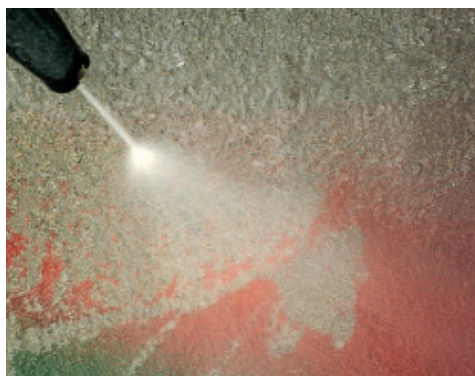
Lavaggio con acqua in pressione di calcestruzzo trattato con WallGard Graffiti Barrier
