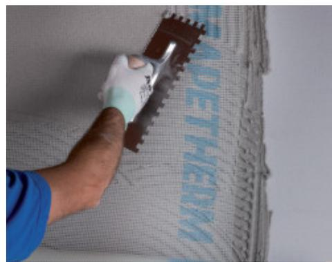
*Esecuzione della rasatura armata con interposizione della rete Mapetherm Net*
