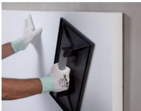
*Pressatura del pannello durante la posa, necessaria per garantire la corretta adesione al supporto*
