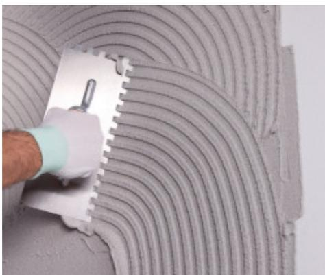
*Stesura della prima mano di rasatura con Mapetherm AR1 GG*
