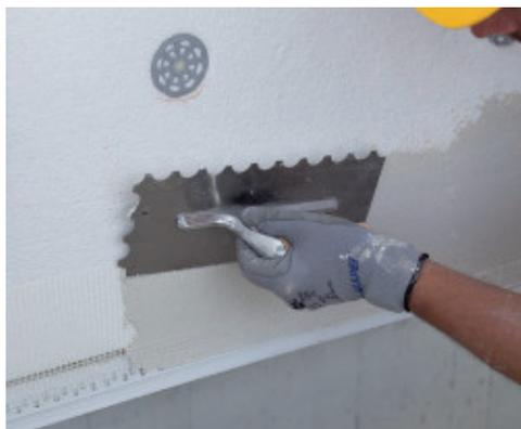
Posa di Mapetherm Rompigoccia con Mapetherm AR1 Light
