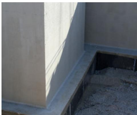
Impermeabilizzazione delle superfici verticali con **Mapelastic Foundation**
