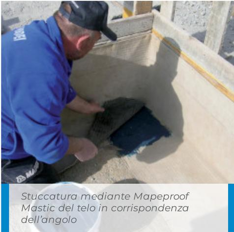
Stuccatura mediante Mapeproof Mastic del telo in corrispondenza dell'angolo
