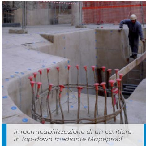
Impermeabilizzazione di un cantiere in top-down mediante Mapeproof
