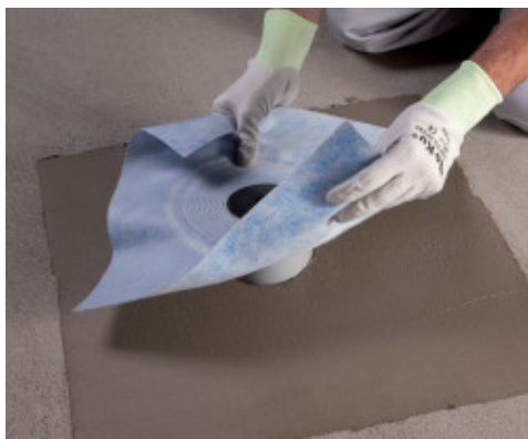
Posa di Drain Vertical, pozzetto di scarico, su Mapelastic
