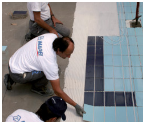
Posa di rivestimento ceramico su Mapelastic
