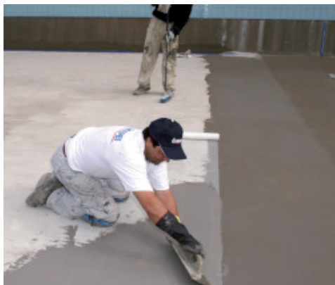
Impermeabilizzazione di una piscina con Mapelastic
