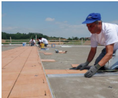
Posa di ceramica con Kerabond + Isolastic
