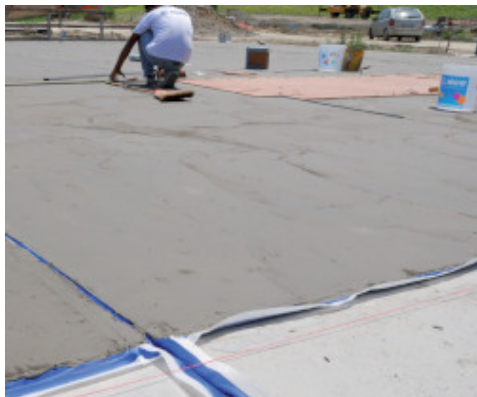
Impermeabilizzazione dei massetti con Mapelastic e Mapeband
