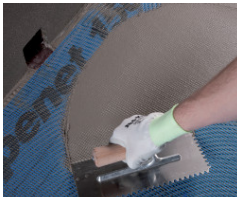
Stesura di Mapelastic su Mapebet 150
