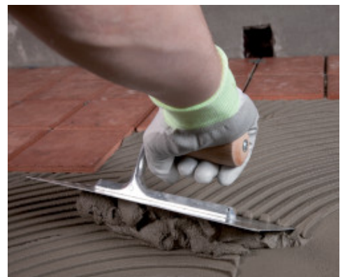
Posa di Granirapid su terrazzo impermeabilizzato con Mapelastic
