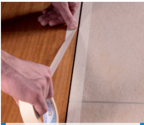
Preparazione protettiva per la sigillatura del giunto
