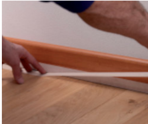
Preparazione protettiva per la sigillatura del giunto
