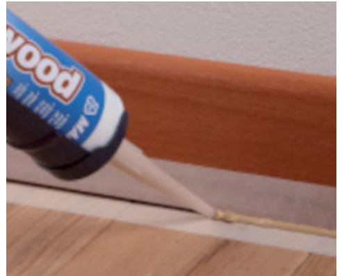
Riempimento del giunto
