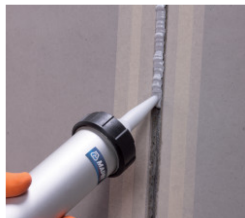
Applicazione di Mapeflex PU40
