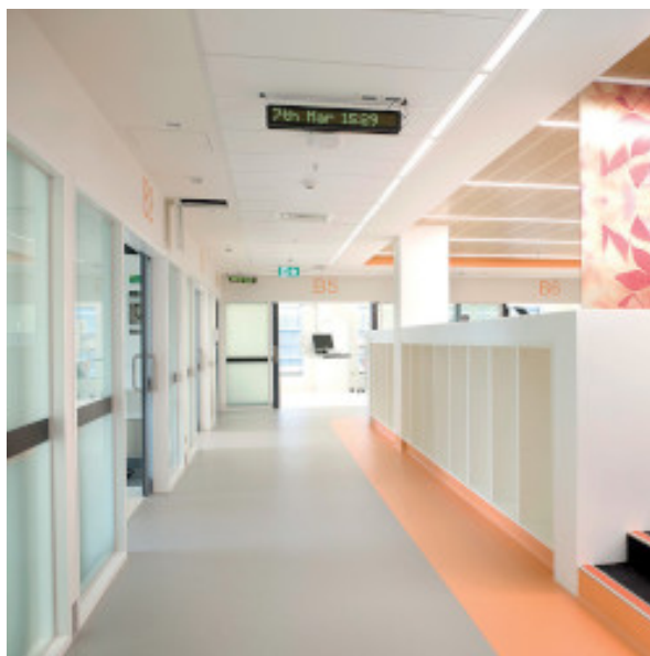
Esempio di posa di linoleum effettuata su livellatura in Ultraplan - Victorian Comprehensive Cancer Centre - Melbourne - Australia
