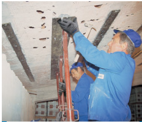
Messa in opera di placca metallica per rinforzo strutturale
