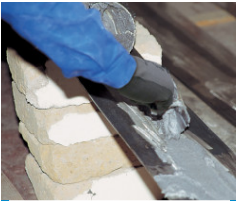
Stesura di Adesilex PG1 su placca metallica
