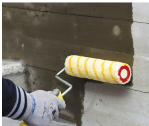
Applicazione a rullo di Planiseal WR 100
