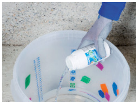
Aggiunta di Mapetard ES all'acqua d'impasto di Planitop Rasa & Ripara R4 o Planitop Rasa & Ripara prima della miscelazione
