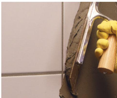
Rasatura di rivestimento esistente con Planipatch
