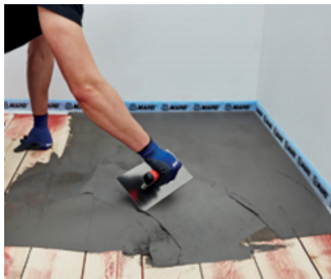
Applicazione di Planipatch Xtra + Latex Plus su supporto in legno
