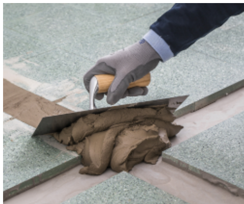
Riempimento di traccia con Planipatch Xtra
