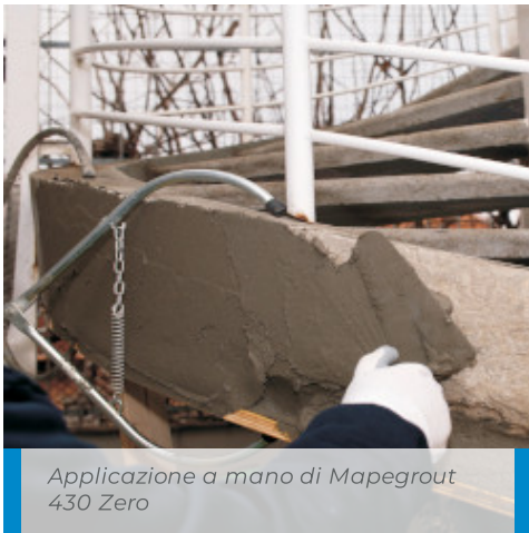
Applicazione a spruzzo di Mapegrout 430 Zero
