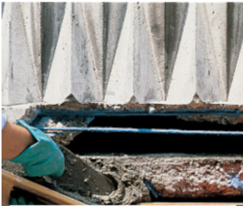
Esempio di riparazione di un balcone con Mapegrout T40
