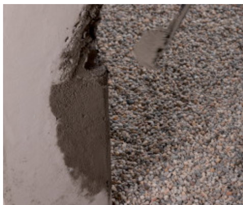
Applicazione a cazzuola di Mapegrout LM2K
