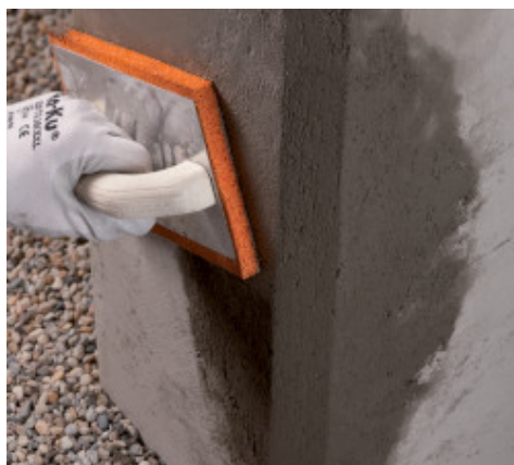
Frattazzatura di Mapegrout LM2K
