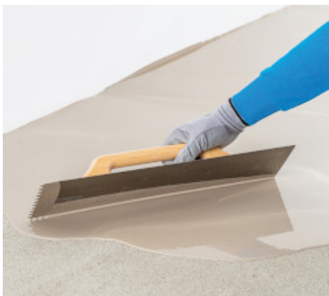
Applicazione di Ultraplan Contract
