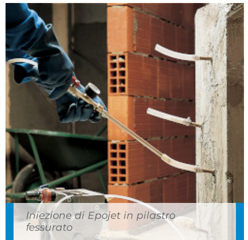
Fissaggio degli iniettori con Adesilex PG1
