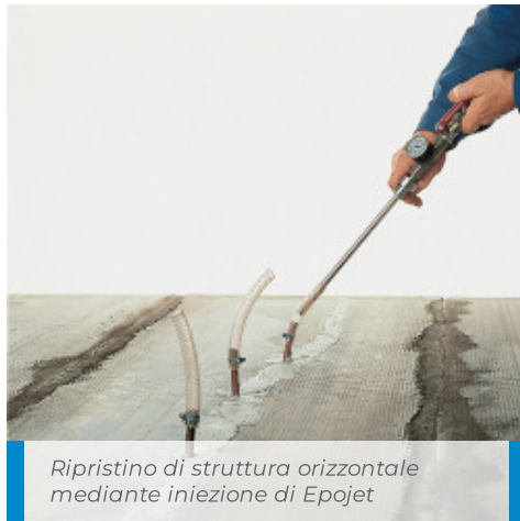
Fissaggio degli iniettori con Adesilex PG1
