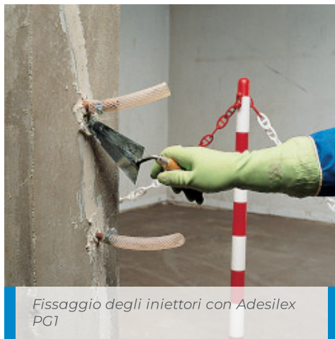
Iniezione di Epojet in pilastro fessurato
