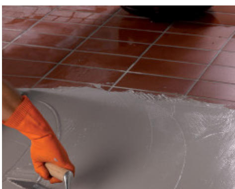
Stesura del secondo strato di Monolastic su Mapenet 150
