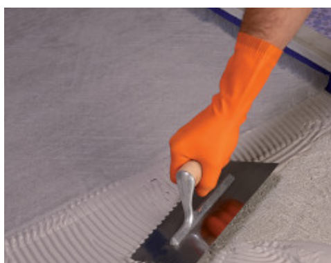
Stesura del primo strato di Monolastic armato con Mapetex Sel N su nuovo massetto
