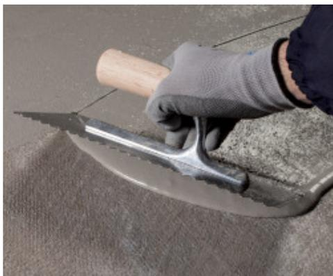
Seconda mano di **Mapelastic Turbo** su prima armata con **Mapetex Sel N**
