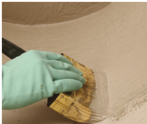
Impermeabilizzazione di dettagli a pennello
