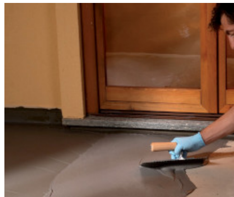
Impermeabilizzazione di terrazzo a spatola
