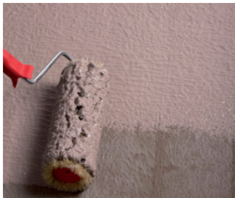
Impermeabilizzazione di terrazzo a rullo
