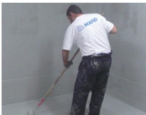
*Mapelastic Foundation steso a rullo in un intervento di impermeabilizzazione in controspinta*
