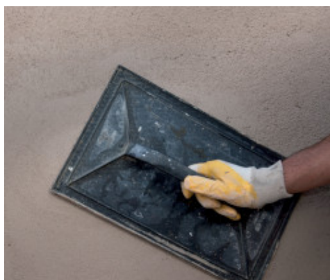
Ripianatura di Mape-Antique NHL Eco Intonaco
