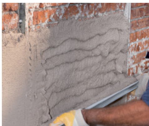
Staggiatura di Mape-Antique NHL Eco Intonaco
