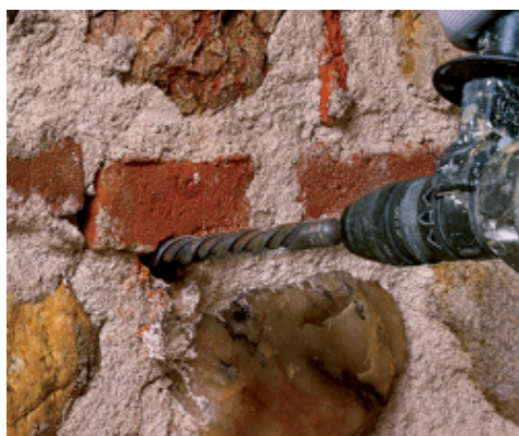
Realizzazione dei fori per Mapenet EM Connector
