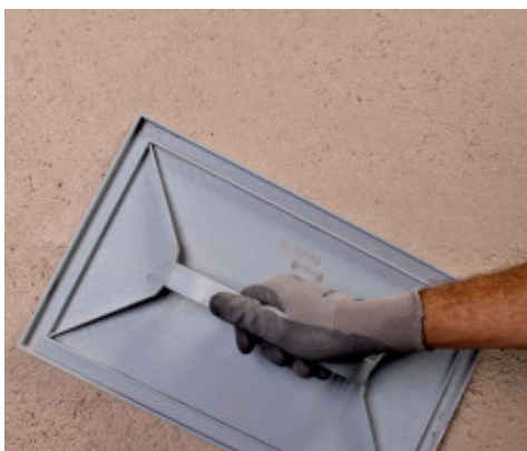
Ripianatura di Mape-Antique NHL Eco Strutturale 10
