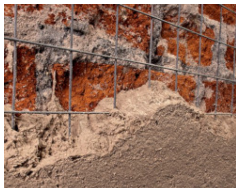
Particolare Mape-Antique NHL Eco Strutturale 10 in abbinamento a rete in acciaio inox
