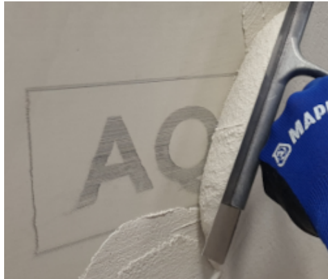
Rasatura di Aquapanel
