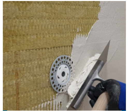
Rasatura di pannelli in lana di roccia
