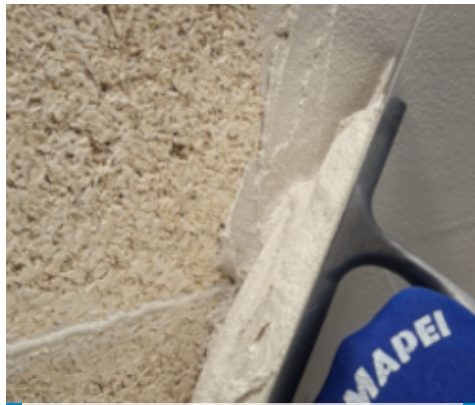
Rasatura di pannelli e blocchi in calce canapulo
