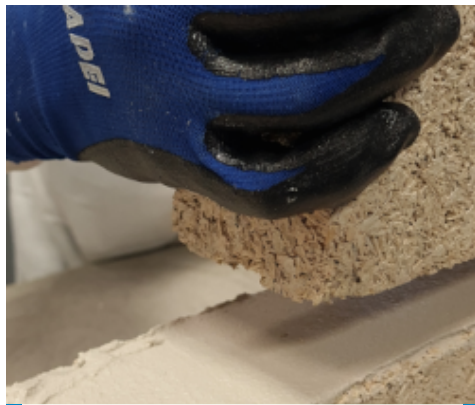
Costruzione di muratura con blocchi in calce canapulo
