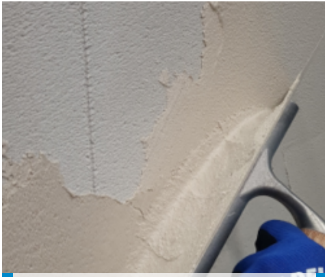
Rasatura di blocchi in calcestruzzo aerato
