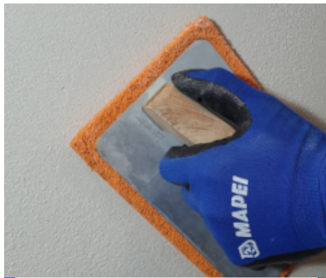
Frattazzatura con frattazzino di spugna
