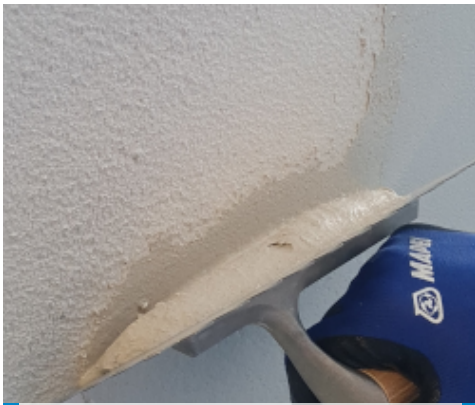
Rasatura di intonaco alleggerito termico
