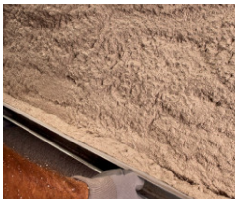
Staggiatura di Mape-Antique NHL Eco Strutturale
