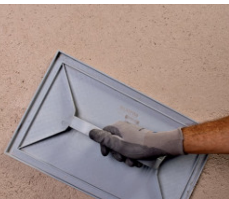
Ripianatura di Mape-Antique NHL Eco Strutturale
