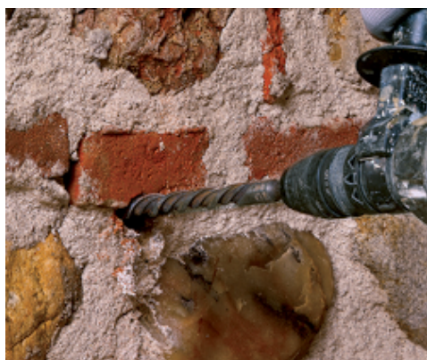
Realizzazione dei fori per Mapenet EM Connector
