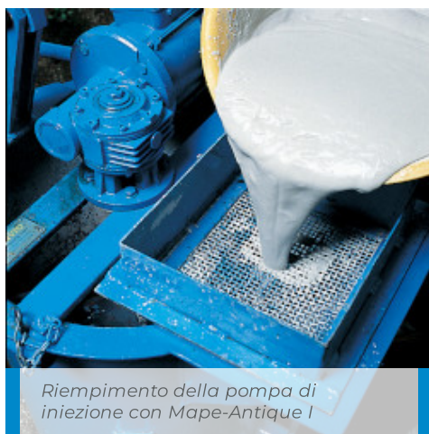
Iniezione di consolidamento con Mape-Antique I
