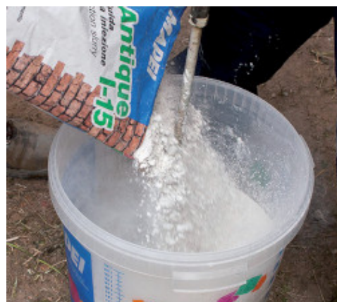
Preparazione di Mape-Antique I-15
