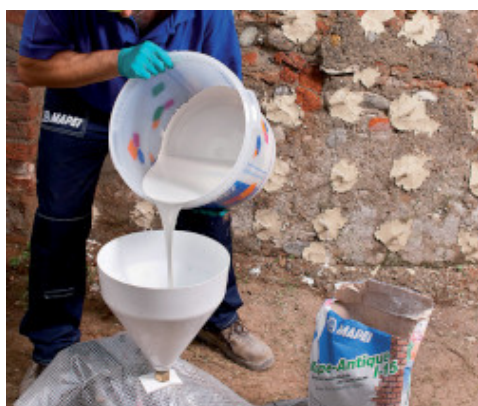
Riempimento della tramoggia con Mape-Antique I-15
