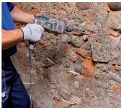
Realizzazione di fori
