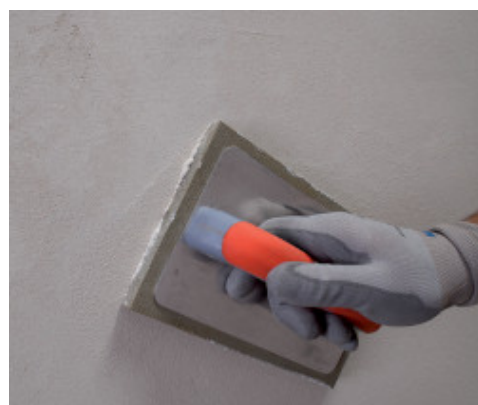
Rifinitura con frattazzino di spugna di Mape-Antique FC Civile
