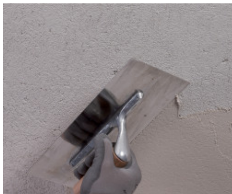
Applicazione di Mape-Antique FC Grosso
