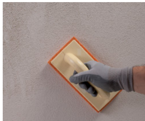
Rifinitura con frattazzino di spugna di Mape-Antique FC Grosso
