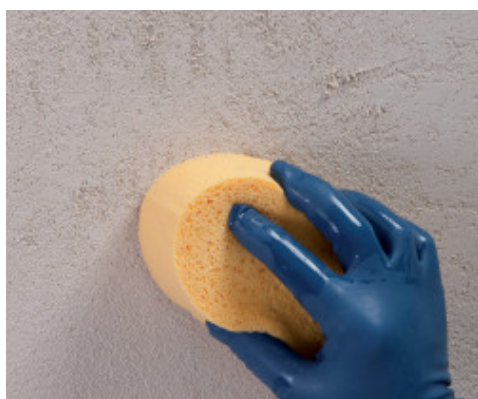
Rifinitura con spugna di Mape-Antique FC Grosso
