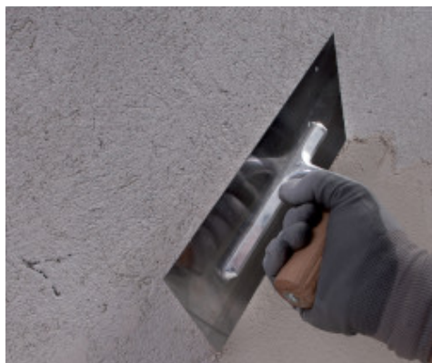
Applicazione di Mape-Antique FC Grosso
