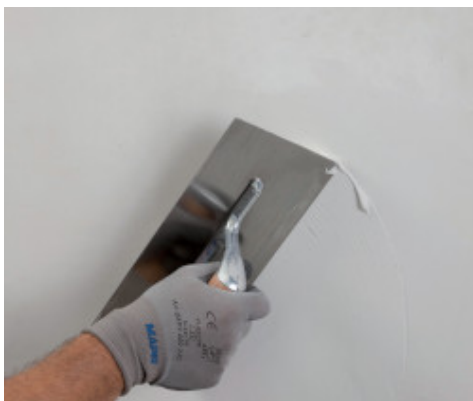
Particolare della fase applicativa di Mape-Antique FC Ultrafine
