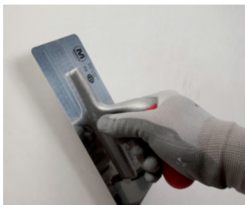
Stesura di un secondo strato di Mape-Antique FC Ultrafine
