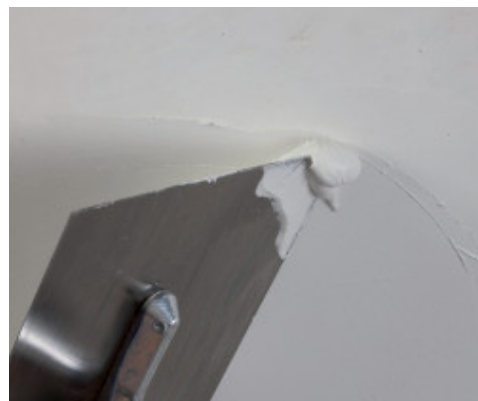
Lisciatura del prodotto con spatola metallica piana
