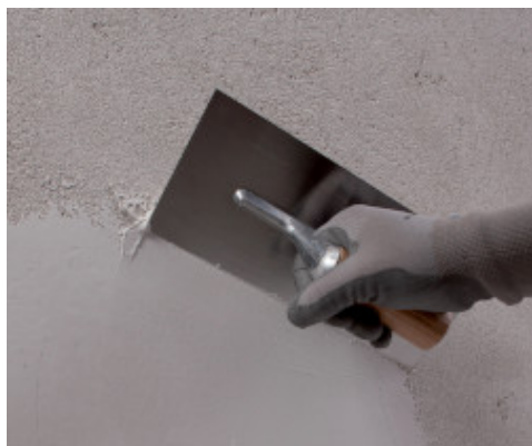
Stesura di un primo strato di Mape-Antique FC Ultrafine
