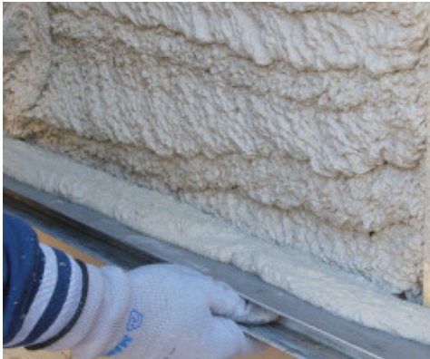
Staggiatura di MapeWall Intonaco Base
