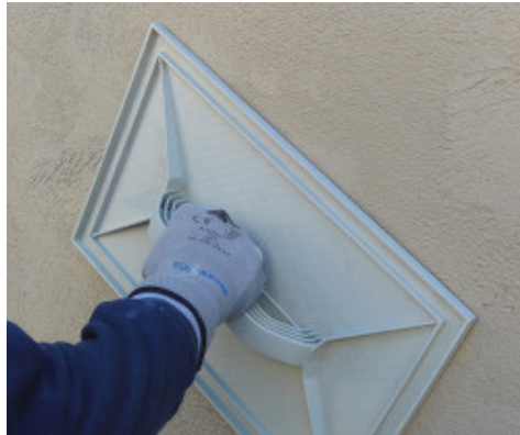
Ripianatura di MapeWall Intonaco Base
