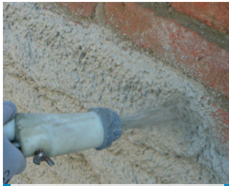
Applicazione con intonacatrice di MapeWall Intonaco Base su muratura in mattoni pieni
