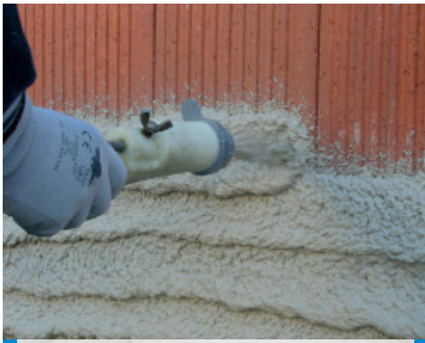
Applicazione con intonacatrice di MapeWall Intonaco Base su nuova muratura in forati
