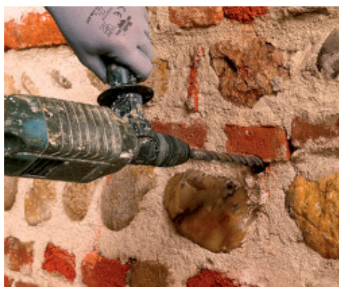
Realizzazione dei fori per MapeNet EM Connector
