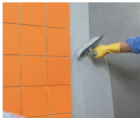
Incollaggio di rivestimento ceramico su MapeWall Intonaca & Rinforza 10
