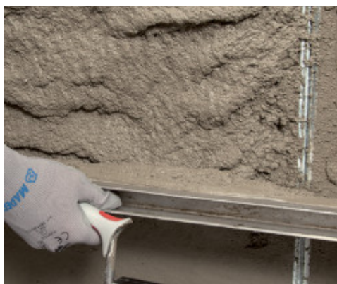
Staggiatura di MapeWall Intonaca & Rinforza 10
