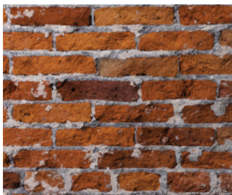
Muratura in mattoni dopo la rimozione dell'intonaco degradato
