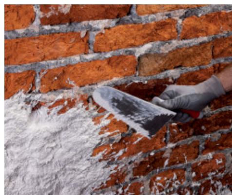
Applicazione di Mape-Antique Rinzafo
