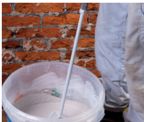
Preparazione di Mape-Antique Rinzafo
