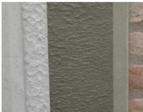
Applicazione di PoroMap Rinzafo Plus su Mapelastich Foundation per la realizzazione del ciclo anticondensa
