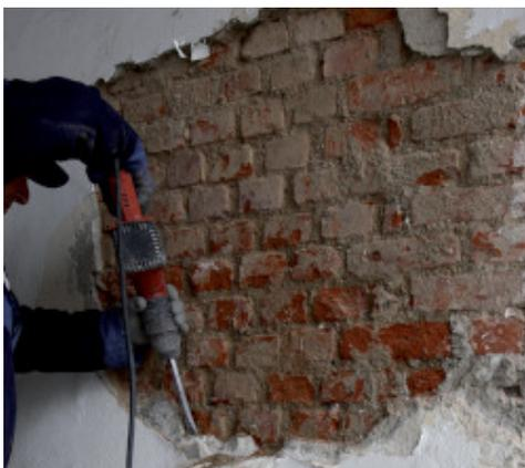
Rimozione dell'intonaco degradato
