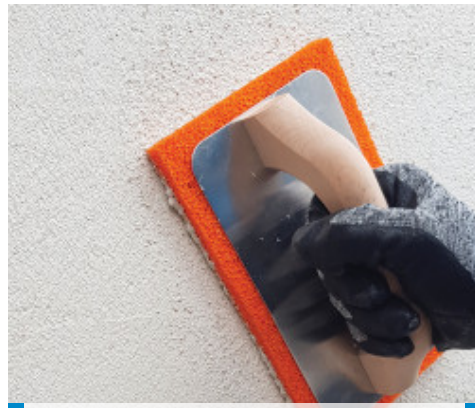
Rifinitura con frattazzino di spugna di PoroMap Finitura Granello
