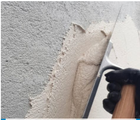
Applicazione di PoroMap Finitura Granello su intonaco stagionato
