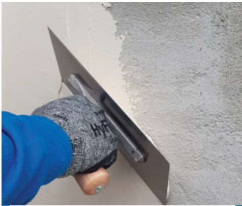
Applicazione di PoroMap Finitura Civile su intonaco stagionato
