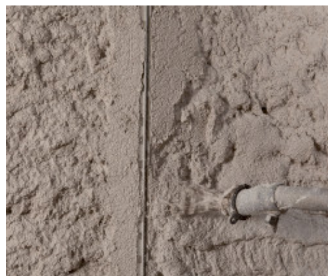
Applicazione di Mape-Antique MC Macchina
