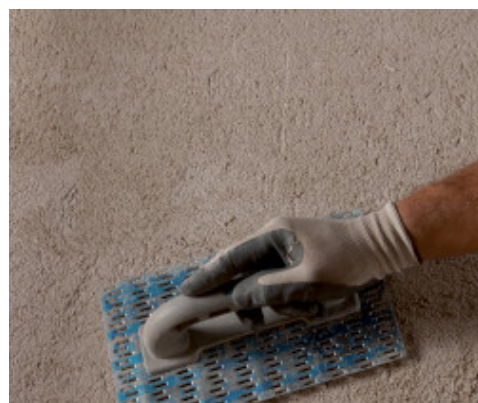
"Rabottatura" di Mape-Antique MC Macchina
