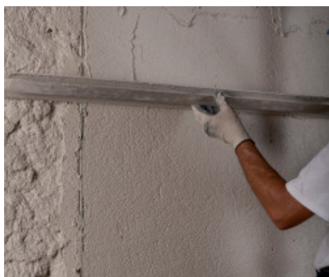
Staggiatura di Mape-Antique MC Macchina
