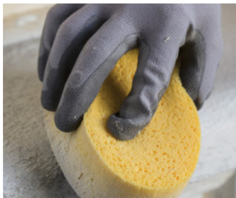
Frattazzatura con spugna di Mape-Antique Ecolastic
