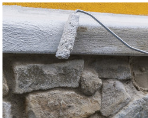
Impermeabilizzazione della copertina di un muro con Mape-Antique Ecolastic
