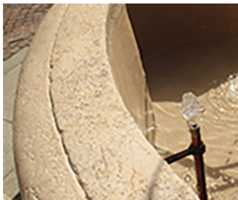
Impermeabilizzazione della vasca di una fontana in pietra
