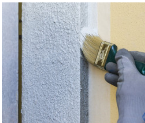
Protezione di cornice di una finestra con Mape-Antique Ecolastic
